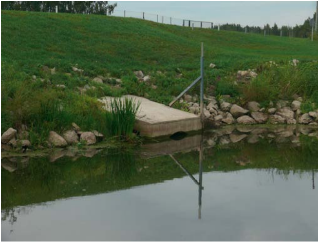
19. attēls. Zvidzianas poldera izplūde uz Lubānu
