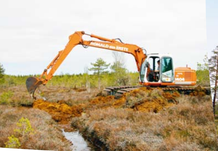
Stiklu purva hidroloģiskā režīma atjaunošana, aizberot grāvjus. Foto: Māra Pakalne
