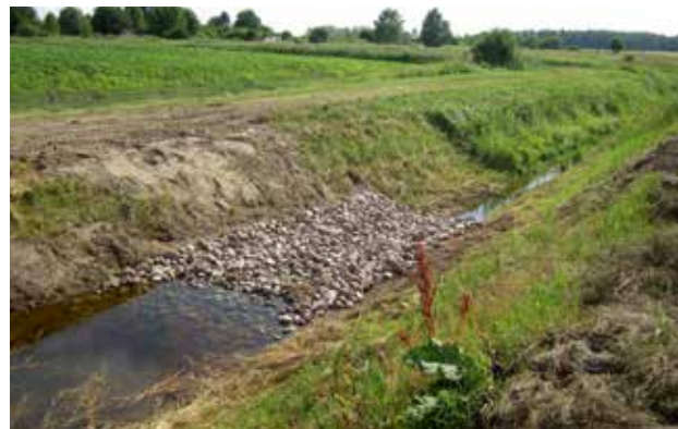
Ūdens līmeņa regulēšanas sliekšnis augu barības vielu koncentrāciju mazināšanai saimniecībā “Vecauce”. Foto: J.Reiņmanis.
