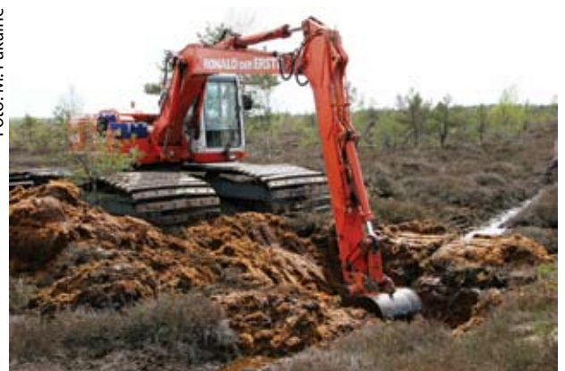
Kūdras aizsprostu būvēšanai uz lielajiem nosusināšanas grāvjiem tika izmantots ekskavators ar 1,5 m platām koka kāpurķēdēm, kas piemērots tieši darbam purvā. For building of dams on the large drainage ditches an excavator was used with 1.5 m wide caterpillars that are appropriate for the work in the mire.
