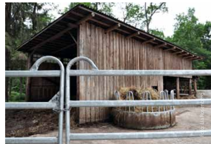
Liellopu nojume ar izbetonētu barošanas laukumu saimniecībā „Vekši”.
