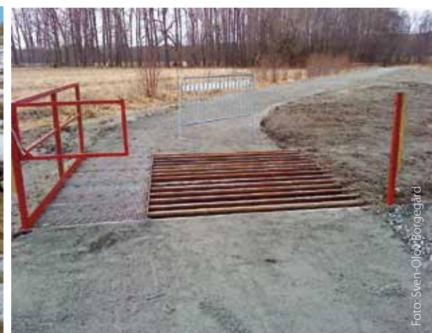
Vietās, kur žoga līnija šķērso ceļu, var uzstādīt vienkāršus, bet cieši aizveramus vārtus. Tomēr ērtāk būs, ja ceļa trasi pārrakstīs ar grāvi, bet tam pāri novietos izturīgu metāla režģi, kura spraugas ir pietiekami platas, lai lopu tām neietu pāri, bet gana šauras, lai tam varētu pāriet cilvēks vai pārbraukt transportlīdzeklis.
