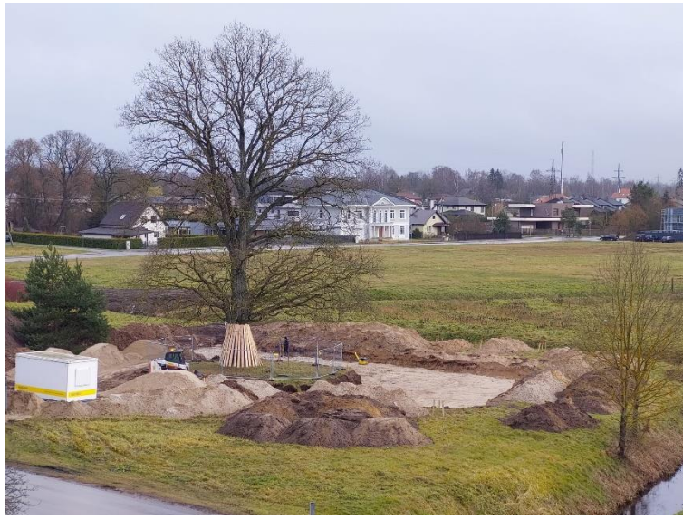
1.att. Būvdarbi Mārupē, Kantora ielā 115 un Kantora ielā 117.
