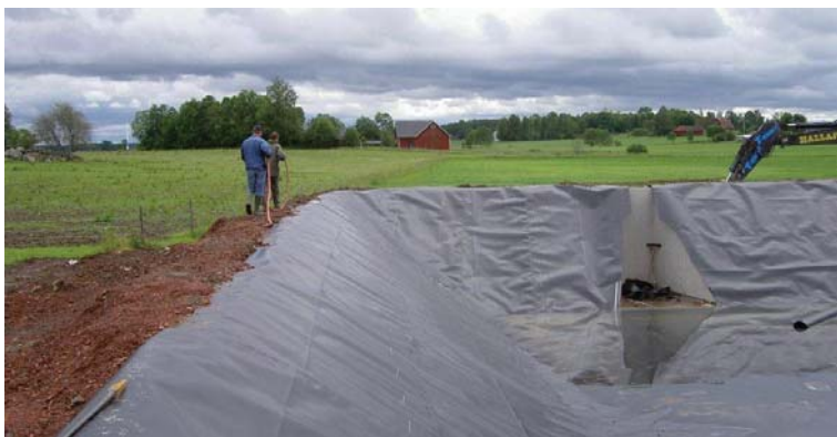
Lagūnas veida krātuves būvniecība, izmantojot necaurlaidīga polietilēna izolācijas slāni.
