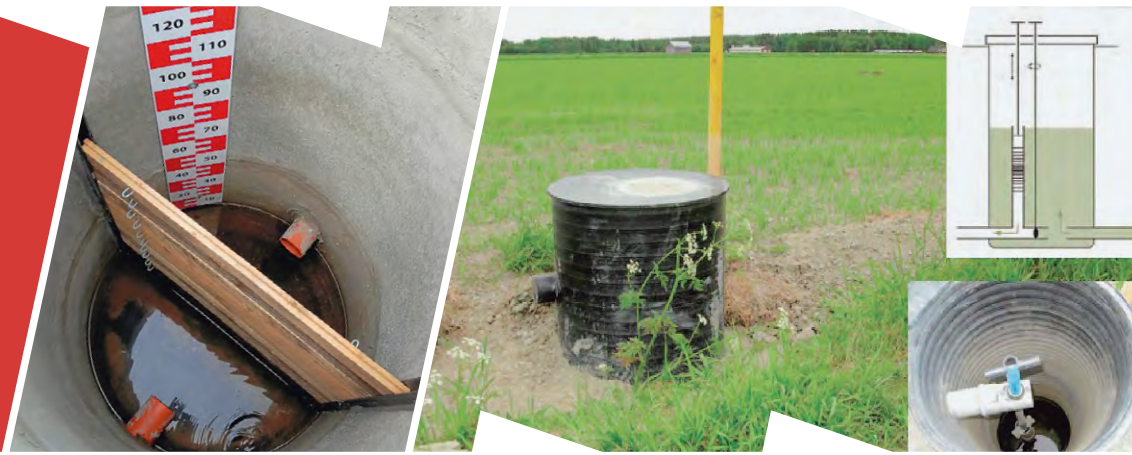
5. attēls. Ar koka dēļiem regulējama aizvaru sistēma kontrolakā. Foto: R. Abaja
