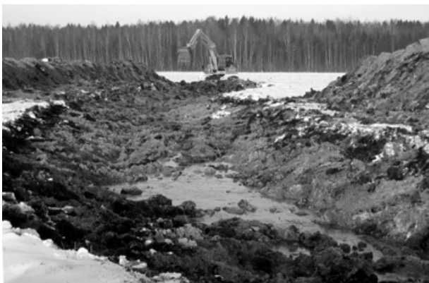
4. attēls. Izraktā grunts tika bērtā jaunās gultnes krastos pārmaiņus vienā un otrā pusē ar aprēķinu, lai vēlāk izlīdzināta tā neveidotu abpusēju valni, kas traucētu plūdu ūdeņiem brīvi izplūst pļavās. Foto: A. Liepa, 08.02.2005. (Skatīt 4. krāsaino attēlu ielikumā)
