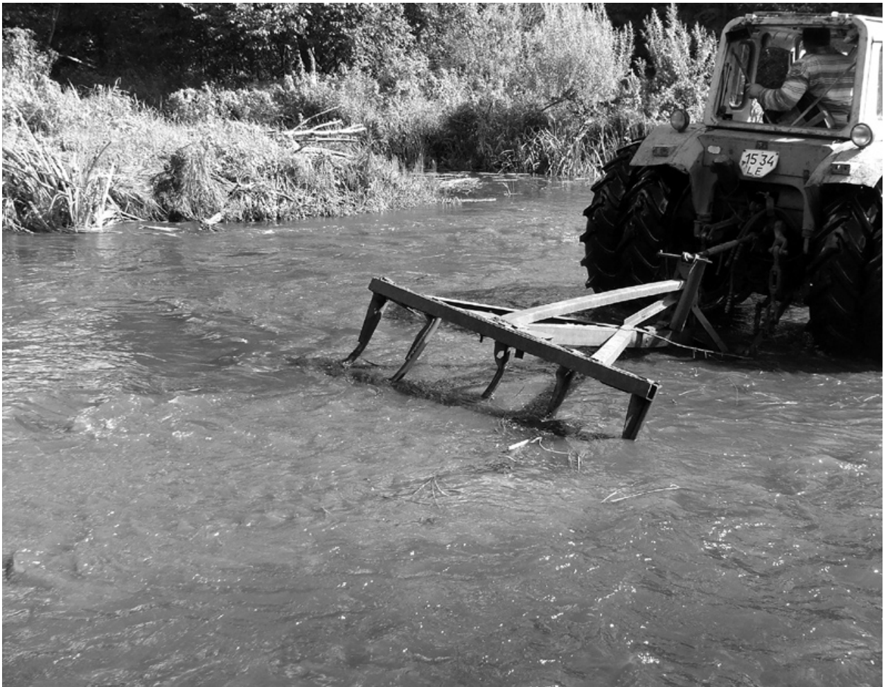
4. attēls. Mehāniskā irdināšana. Gultni pāraugušais sakņu režģis vienlaikus akumulējis lielu daudzumu nogulu. Figure 4. Mechanical loosening of riverbed. The network of roots accumulates large quantities of deposits.
