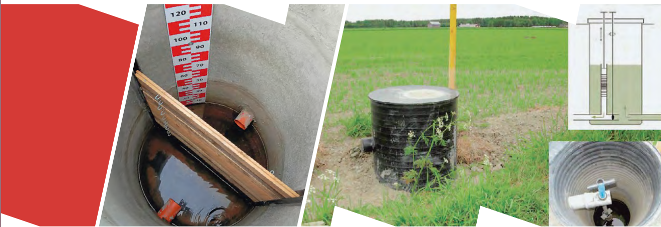
5. attēls. Ar koka dēļiem regulējama aizvaru sistēma kontrolakā. Foto: R. Abaja
