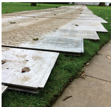
Slodzi izlīdzinošas pagaidu plāksnes no betona.
